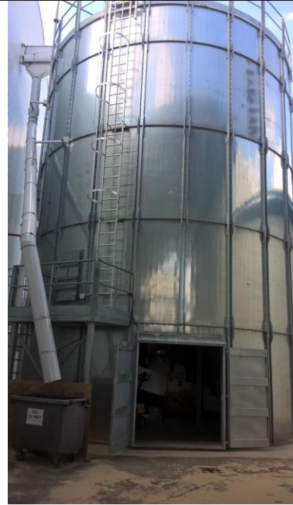
Silo de stockage de copeaux et sciures secs
