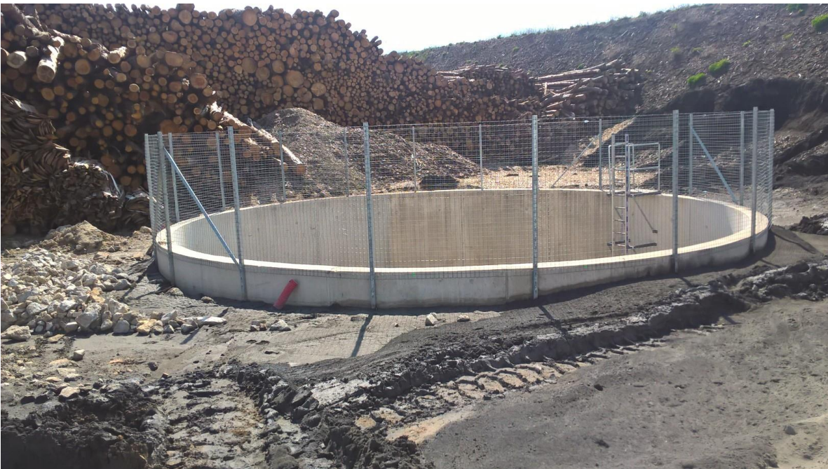
Figure 20 : Photo de l'état du bassin lors de sa construction
